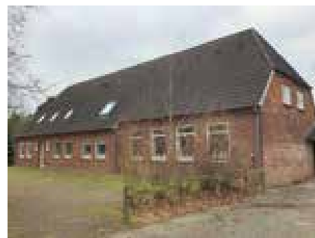
Haus 35 der Grundschule vor der energetischen Sanierung Foto: HRHansen
